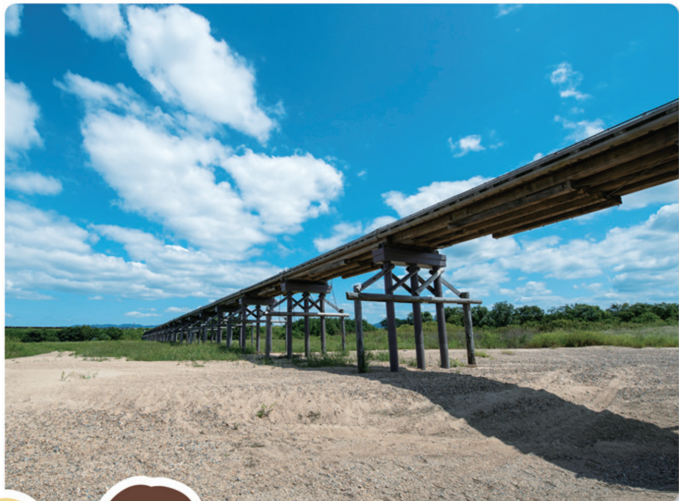
流れ橋 (撮影 堀居 恭子)
